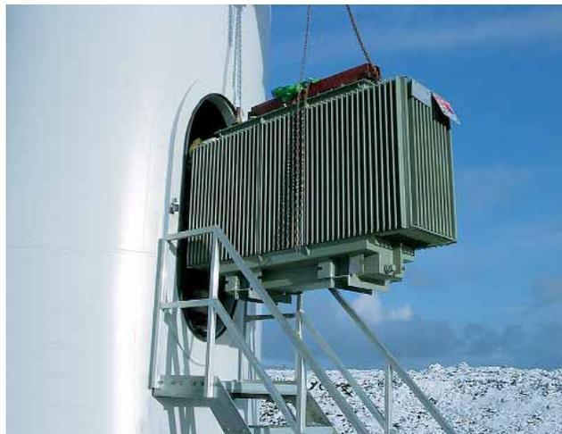
*ENERCON hat bereits bei der Konstruktion von Trafos und Turm darauf geachtet, dass ein evtl. nötiger Trafotausch in nur wenigen Stunden durchgeführt werden kann.*
