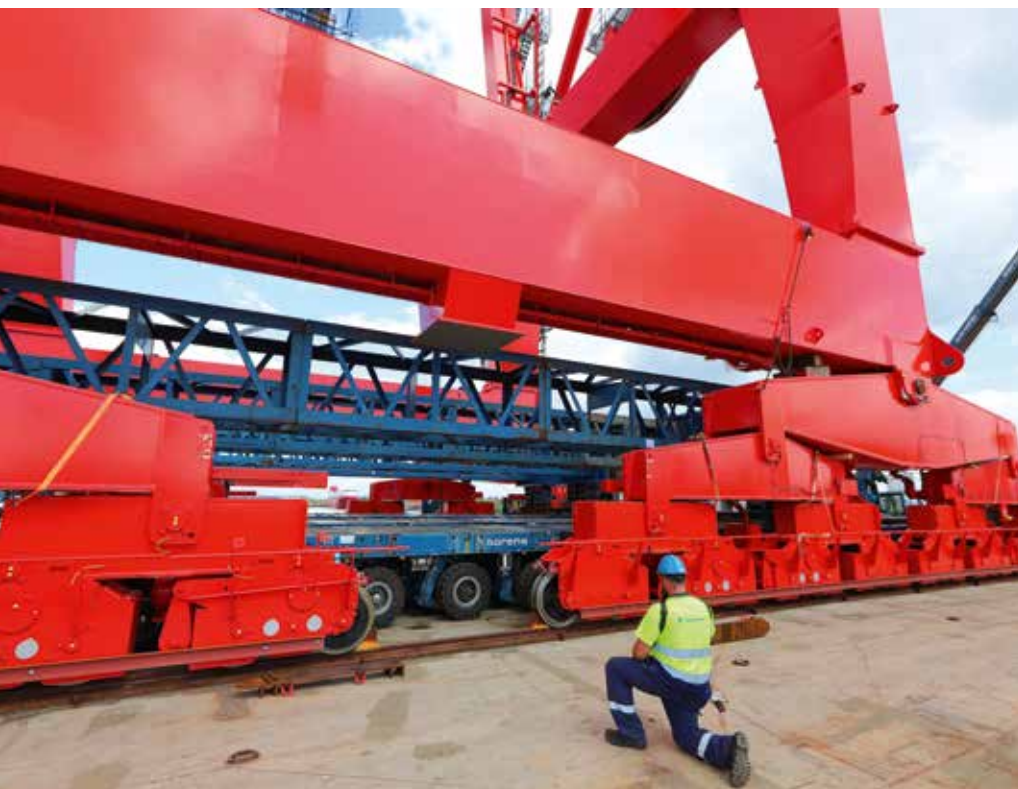
Die gesicherten Laufwerke werden über den Schienen auf der Barge positioniert.
