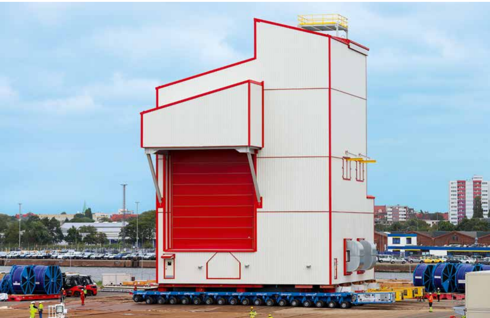
Durch die große Öffnung bringen zukünftig die Fördergurte (links unten im Bild) das zerkleinerte Erz vom Brecher zur Siebanlage.
