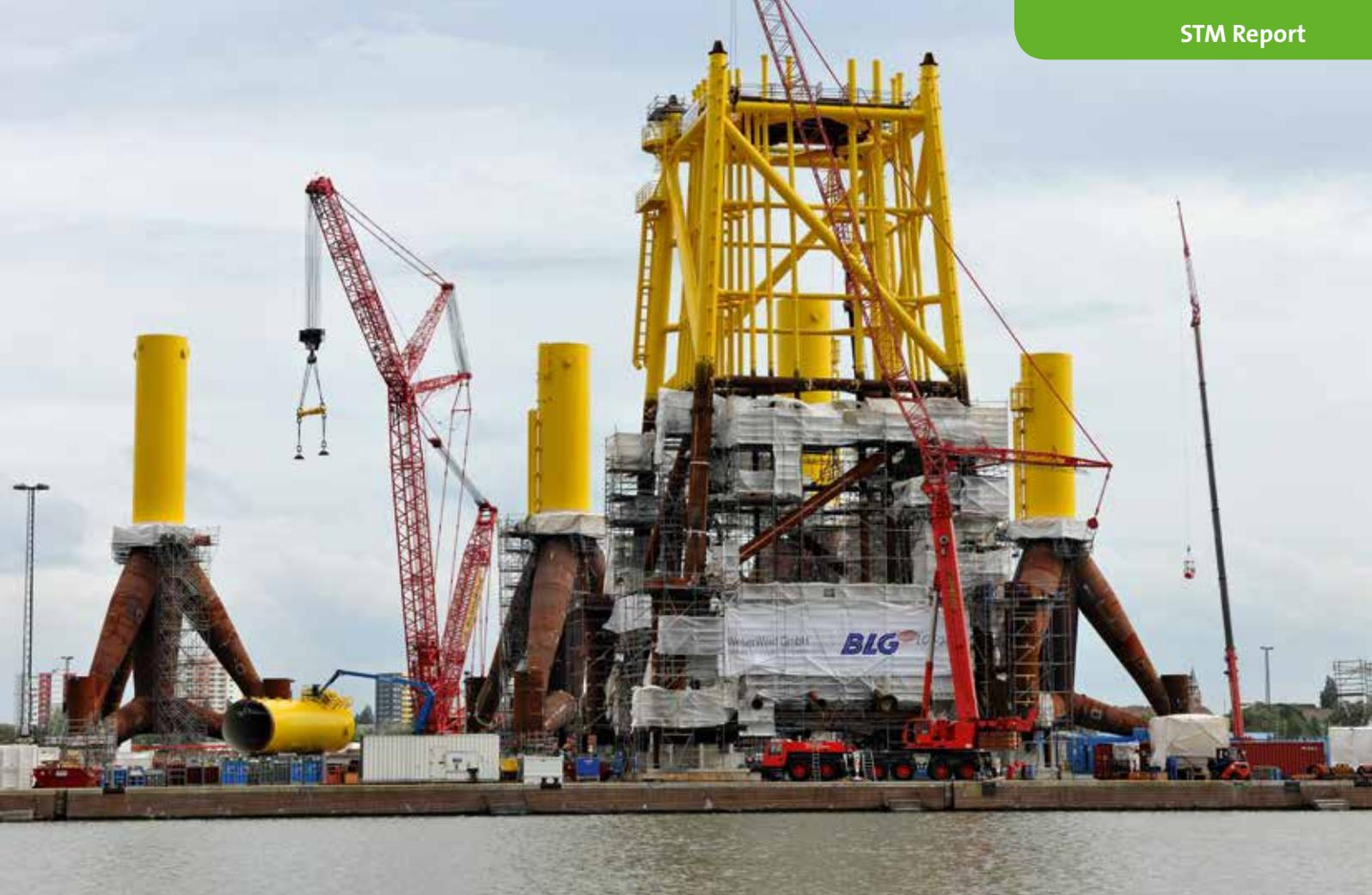
Die Bauarbeiten am Trianel Windpark Borkum gehen Schritt für Schritt voran. Das rund 1.200 t schwere "Jacket", die Unterkonstruktion für die Umspannplattform, ist fertiggestellt und wartet an der Hafenkante auf den Transport zum Baufeld. Im Frühjahr 2013 erfolgt die Hochzeit mit der sogenannten "Topside". Auf ihr sind auf drei Decks die Transformatoren installiert.
