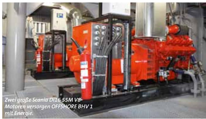
Zwei große Scania DI16 55M V8-Motoren versorgen OFFSHORE BHV 1 mit Energie.
