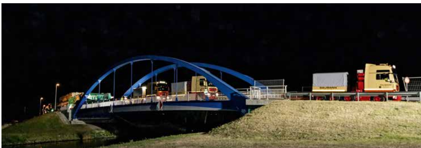
Mit einer Gesamtzuglänge von über 120 m ging es im „Schnecken tempo“ über die Brücke kurz vor dem Ziel.
