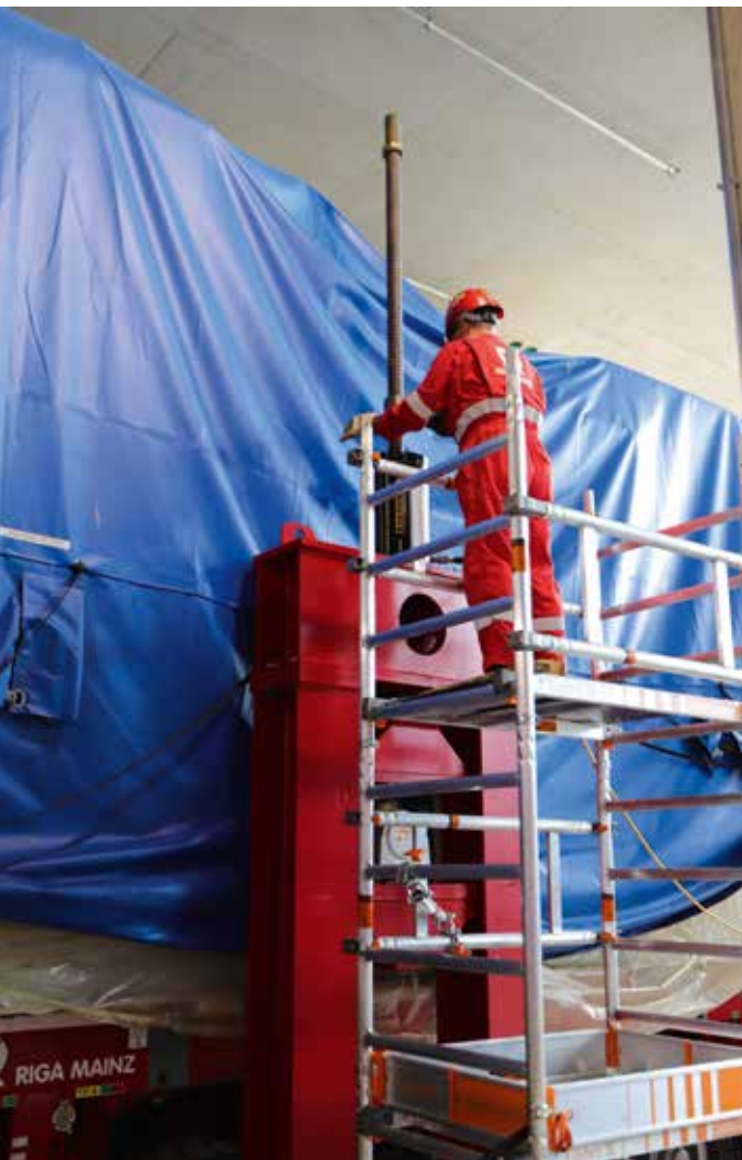
Mithilfe von Gewindestangenhebern wurde dann der Gasmotor vom SPMT gehoben.
