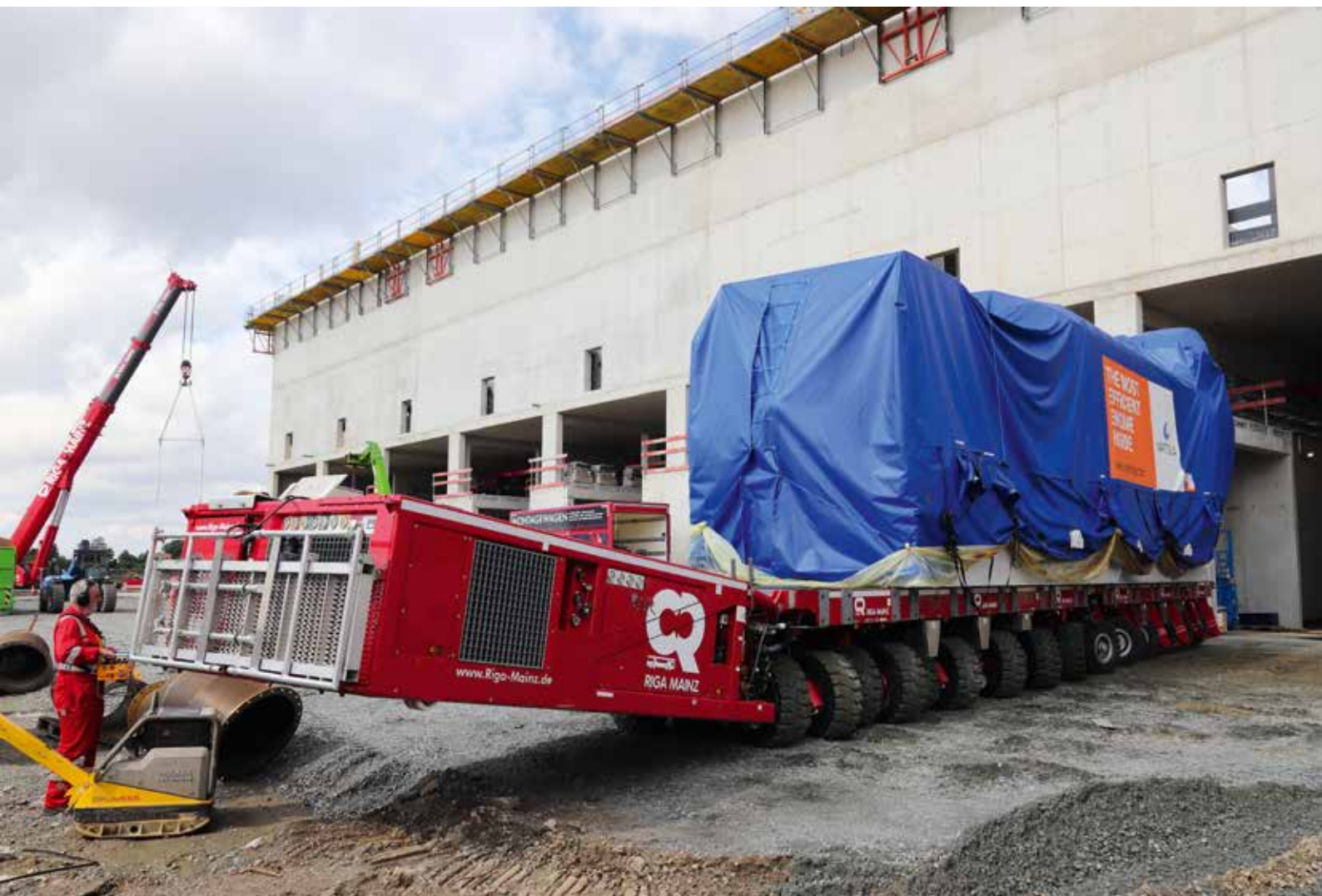
Mit 90 Grad Schwenk vor die Einfahrt des Maschinenhauses.
