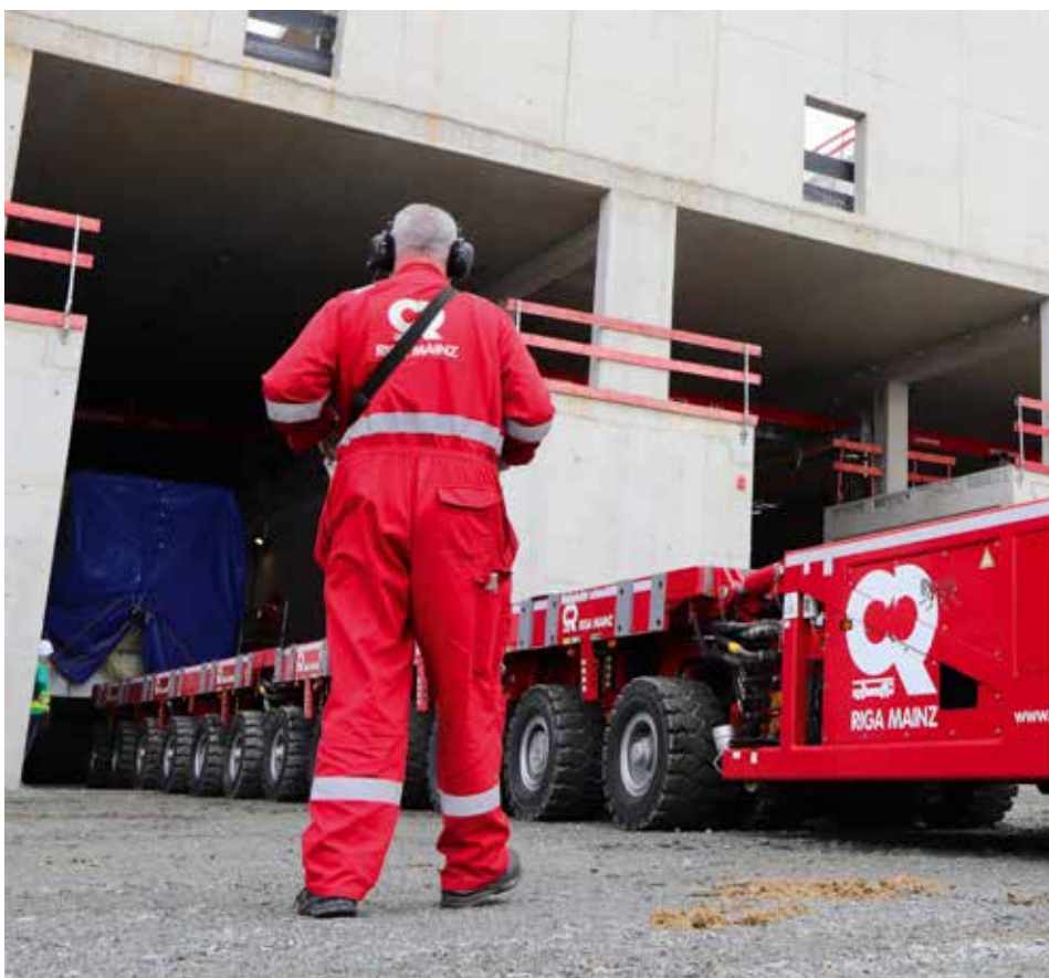
Der SPMT kann die Halle wieder verlassen.
