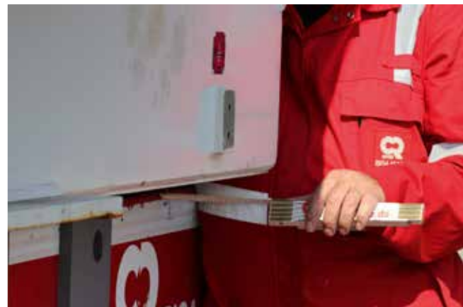
Messen für die genaue Platzierung des Gasmotors auf dem SPMT, dann kann die Last millimetergenau abgesetzt werden
