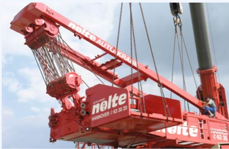
Der Heckbereich des Kranoberwagens wird für die Aufnahme der Gegengewichte vorbereitet.
