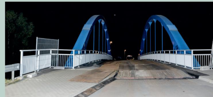
Zum Schutz wird die Brücke mit Hohlkammerplatten überbaut.
