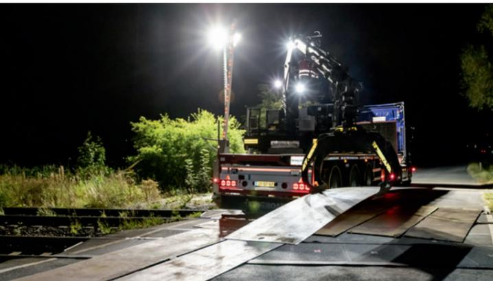
Auch der Bahnübergang wird mit Stahlplatten geschützt.
