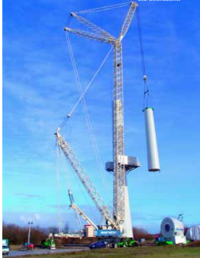
Der CC 8800 in seiner Element - beim Heben des obersten Stahlurmsegments. Bild: www.hadel.net
