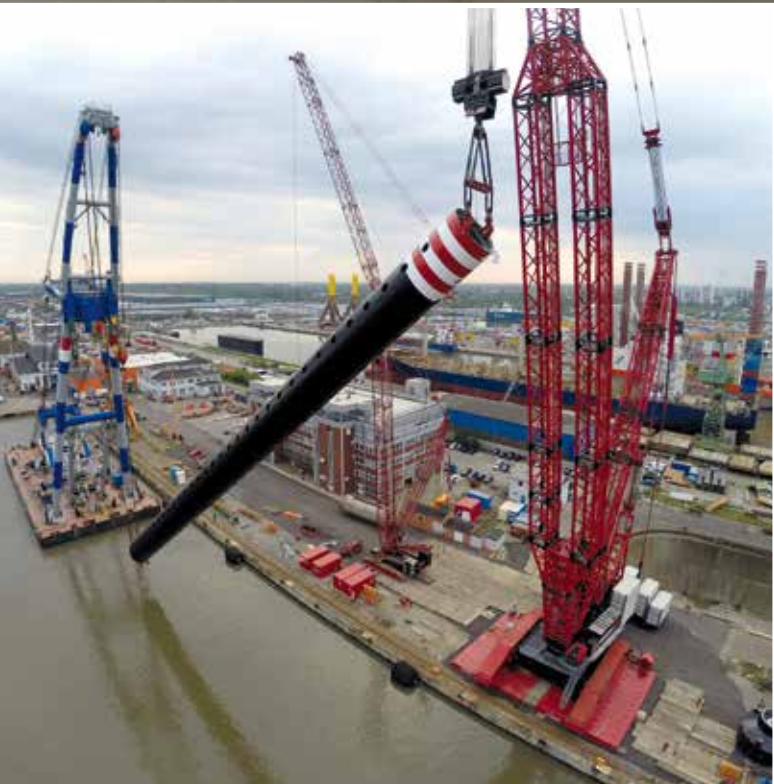
Das rechte, vordere Standbein wurde als letztes montiert, hier die Ladungsaufnahme vom Ponton Wagenborg Barge 8.
