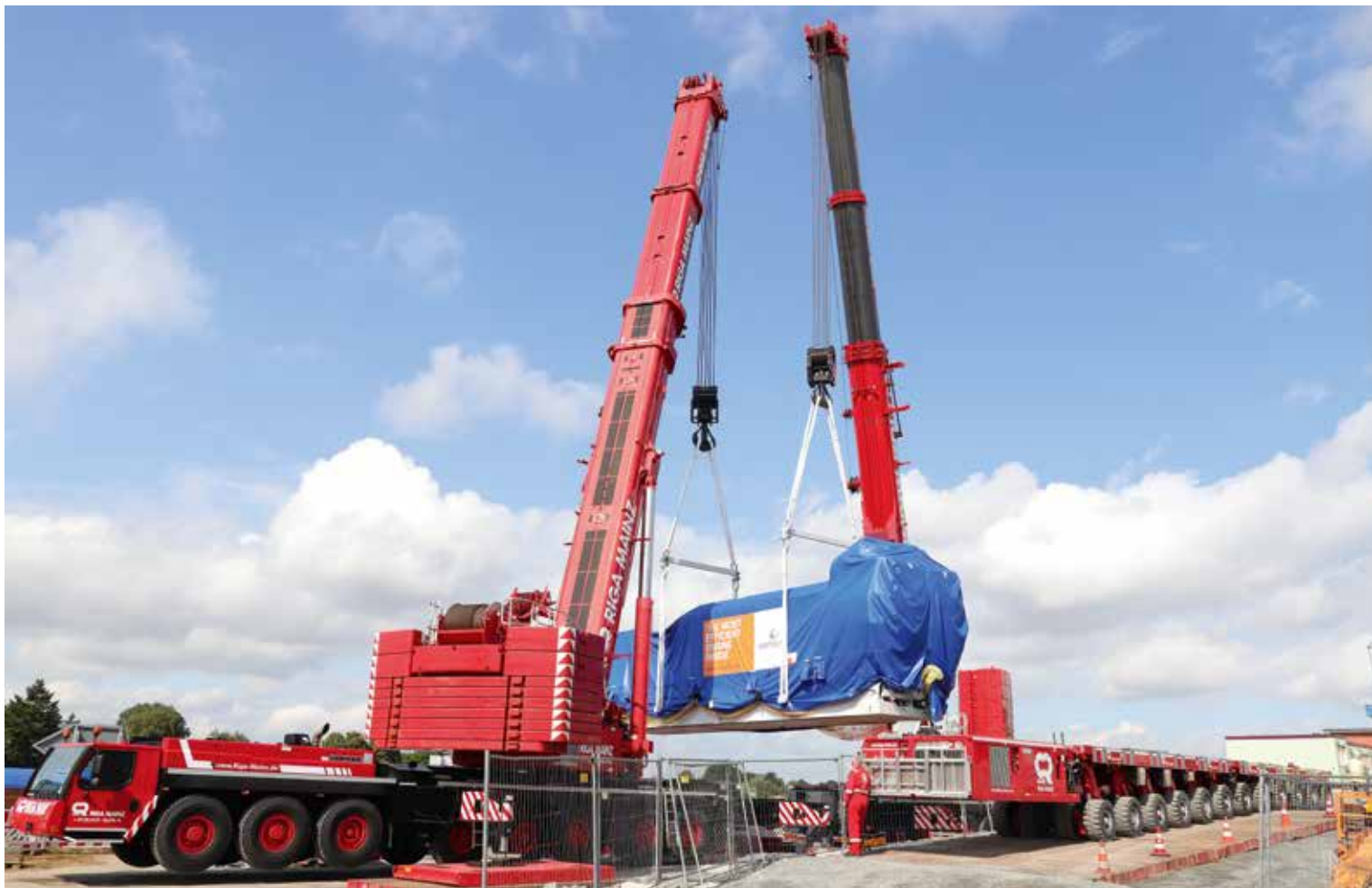
Die Supermotoren werden am Kraftwerkskai vom Binnenschiff auf einen 12-achsigen SPMT gehoben.
