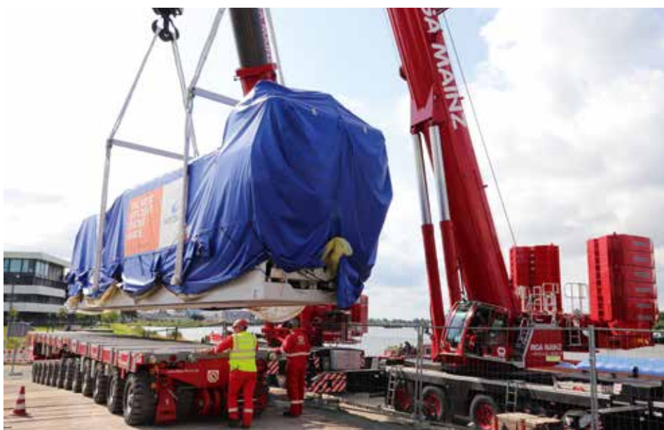
Die 185 Tonnen schwere Last wird im Tandemhub zentimetergenau auf den SPMTs abgesetzt.
