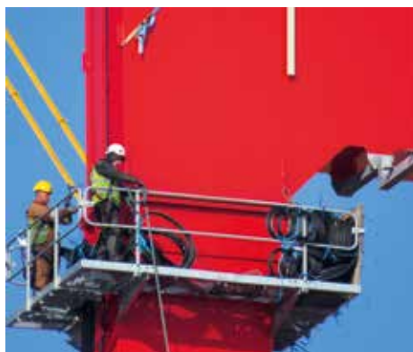
Im ersten Schritt wird der Träger nur mit Splinten in der richtigen Position gehalten.
