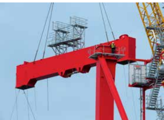
Der erste Querträger erreicht die Monteure in über 65 Metern Höhe.
