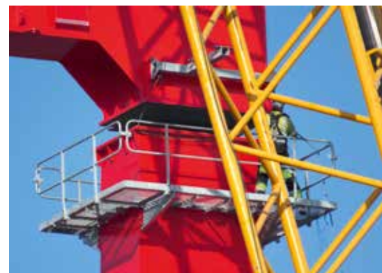
Mit dem Hilfsseil wird das zweite Stützbein auf die richtige Position ausgerichtet.
