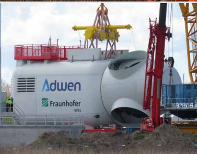
Diese Einheit wird als Ganzes montiert und die Windflügel später einzeln aufgesteckt.
