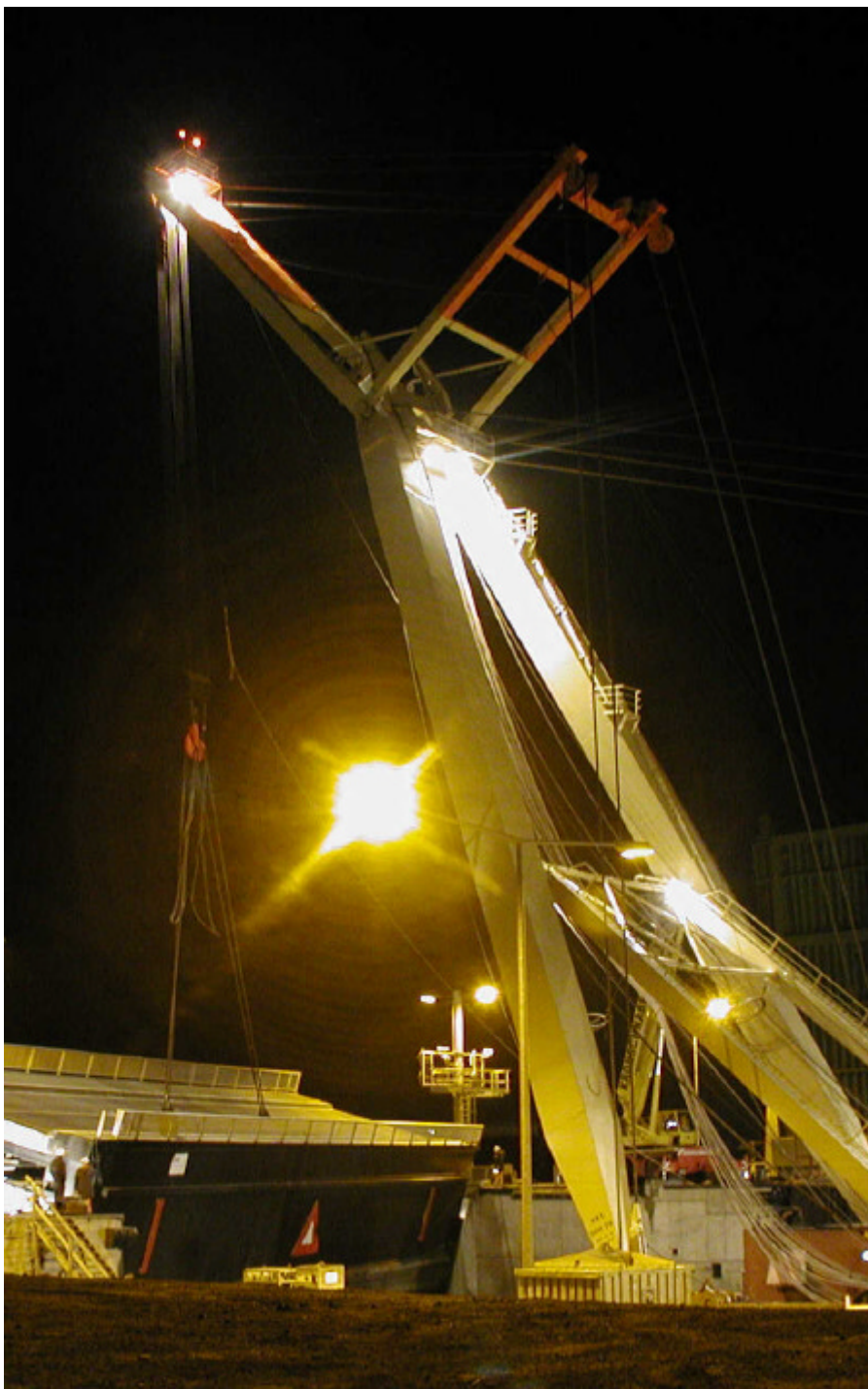
Rund zehn Stunden dauerte die Bergung des Schleusentores.
