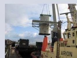
Aufladen der Turmteile am Kai der SSC-Werkhalle in Bremen mit zwei Schwimmkränen auf den Ponton.
